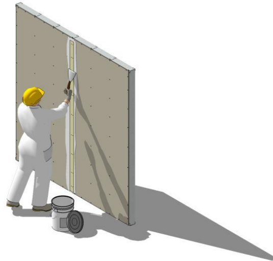
Figura 1. Retiro de exceso de masilla
